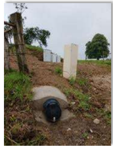
Juin : installation du nouveau trop-plein et finalisation des travaux
